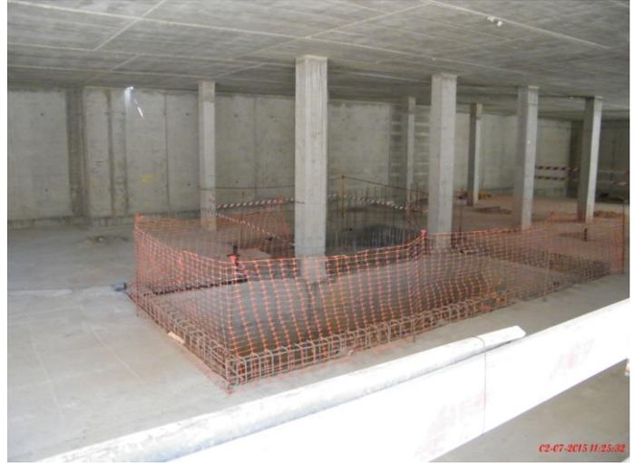
OK – No geral as zonas de desnível encontram-se assinaladas / protegidas,. No entanto onde seja necessário devem colocar-se guarda corpos, estes devem ter dois níveis de perfis acima de laje e roda-cabeça que não podem estar soltos, os “prumos” deve estar bem fixos e estáveis. **Risco de queda em altura.** Prazo correção: **Imediata.**
